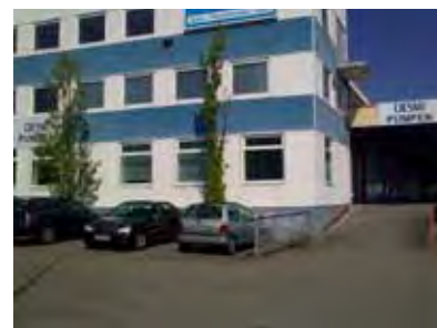
DESMI GmbH Rotan Pumpengesellschaft in Hamburg, Germany
